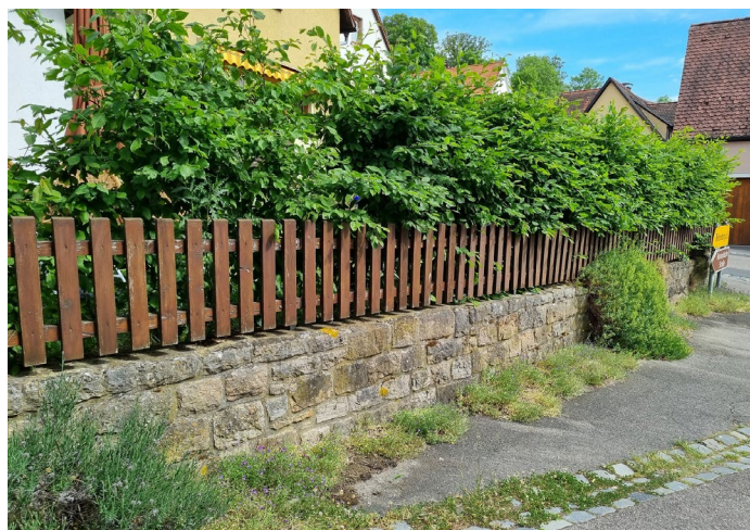
Abb. 4: Verfugtes Mauerwerk. Auch hier konnten Eidechsen nachgewiesen werden.
