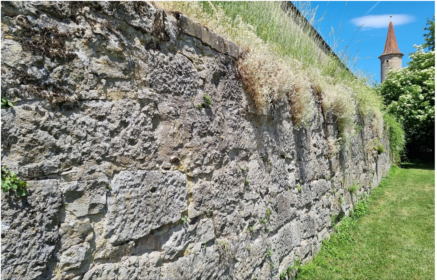
Abb. 15: An der stark verputzten Stadtmauer in Rothenburg konnte ich keine Mauereidechsen nachweisen.
