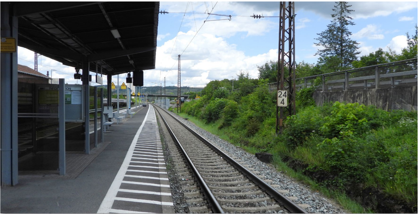
Abb. 138: Gleis 3 im Bahnhof von Karlstadt am 14.7.2024.
