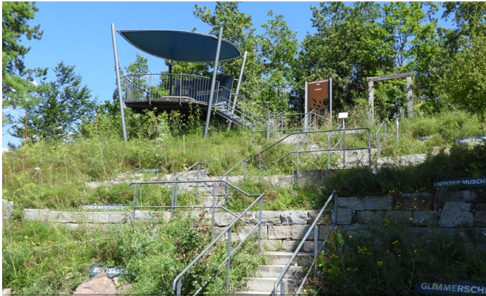
Abb. 176: Aussichtsplattform terroir f Karlstadt mit terrassierten Steingarten am 14.7.2024.
