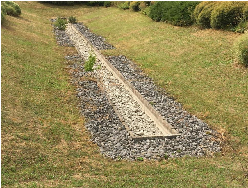
Figure 1 : aménagement favorable au Lézard des murailles sur le site du Grand Troyes
