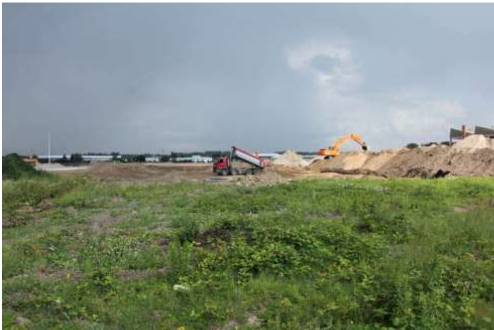
Abb. 1: Bebauung der ehemaligen Monitoringfläche ID 17.
